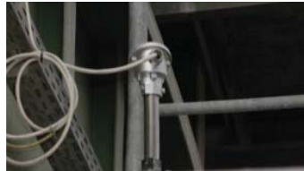
Medición a altas temperaturas en un horno de cal - con transmisor para cabezal montado a distancia
