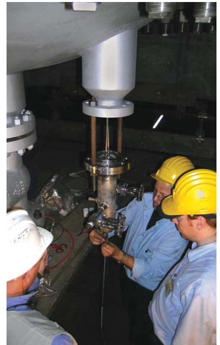
Instalación de un termopar multipunto
